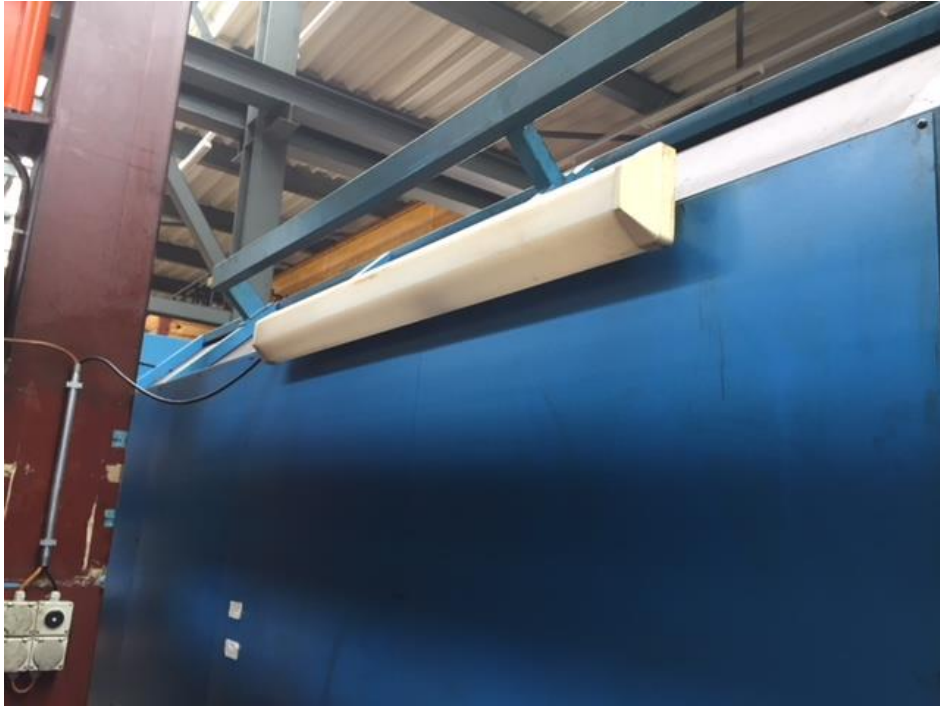
Maschine von hinten, hat Eingangstür für in den Maschinenraum von hinten
