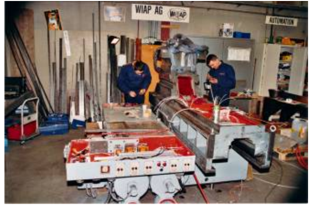
Die Schlittenführung wurde mit SKC neu belegt. Die ganze Schmierung verbessert und erneuert. Die komplette Schlittenrevision in der Schweiz dauerte 6 Wochen. WU4302
