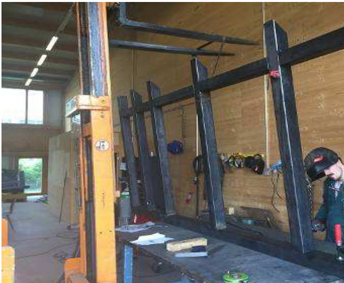
Bild 73: Jim beim Schweißen des Teile Ablage Unterrahmen
