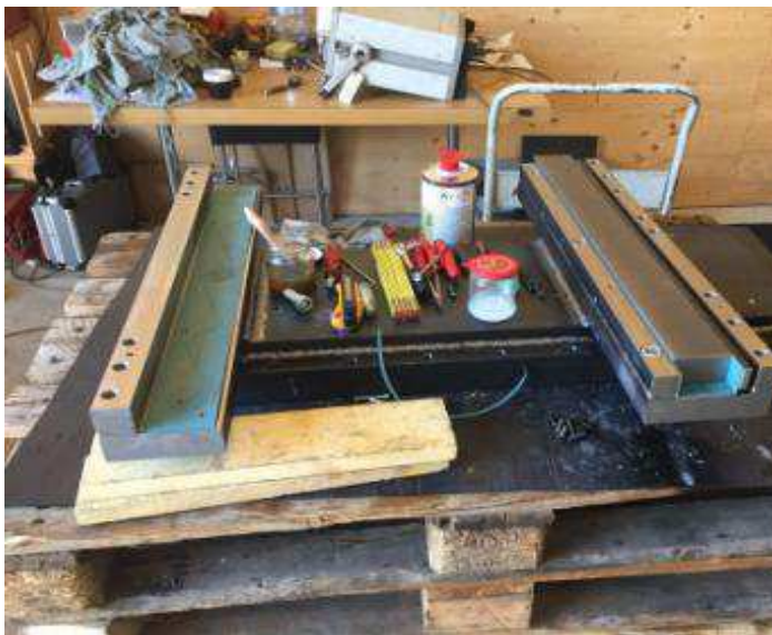
Bild 24: Gleitbelag Test mit Schmierbahnen vorher einfräsen
