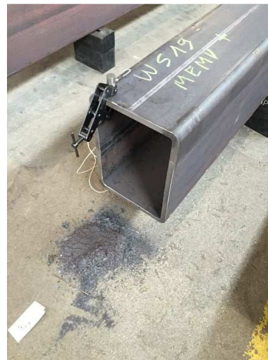
P6: Das Bauteil verliert Zunder durch das WIAP® MEMV® Verfahren
