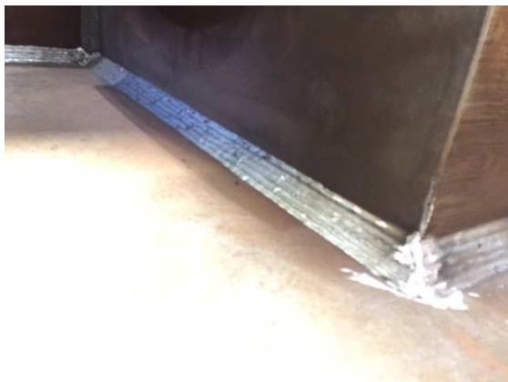
Figure 13: énorme quantité de soudures donne la force de membre. 4 x M24 Avec un peu moins de 72 tonnes, était nécessaire.
