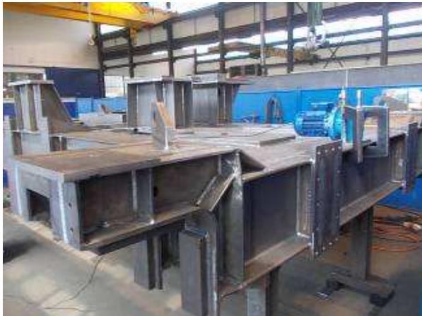
Foto 6): Auch Kranlaufwagen werden mit Vibration entspannt. (Foto CH 2012 hpw)
