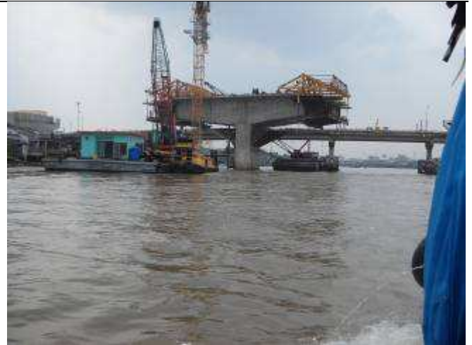
P36. Dann plötzlich wieder dieser Technik Sprung, Hier gibt es eine neue Brücke.
