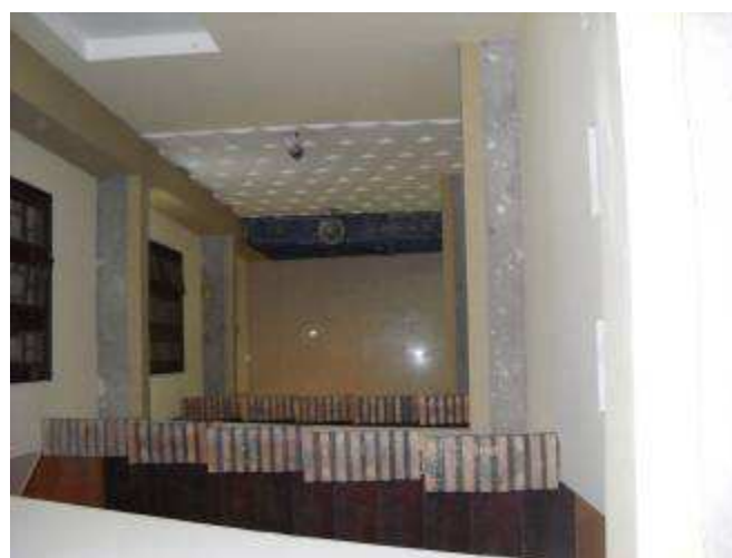
P16: Treppenhaus von unten, das Haus ist hoch
