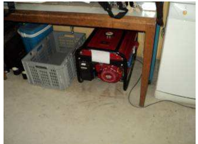
Foto 44: Hier ist ein Generator den wir in der Schweiz im Ricardo kaufen konnten für wenige hundert Franken mit 400 Volt, 6,5 KW.
