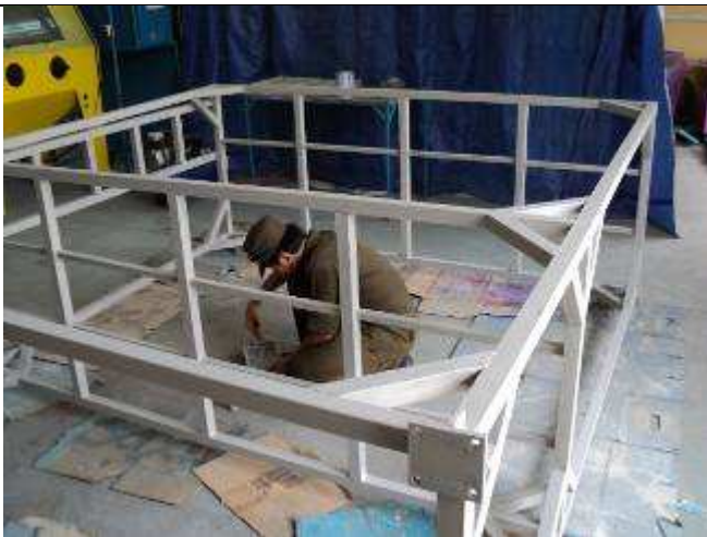
Foto 10: Langsam aber sicher, wird unser Rollgerüst fertig.
