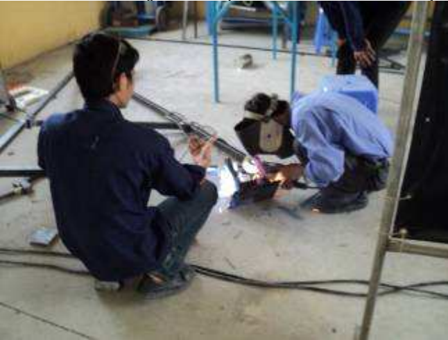
Photo 12: Wir haben noch einen anderen Kran begonnen der nur 2.9 Meter hoch ist. Die Tore sind ja 3 Meter hoch, damit wir alle Hallen damit anfahren können. Schweißen tut der Lehrer Chef Robinson. Die Lehrer genießen es, dass sie endlich mal was tun dürfen.
