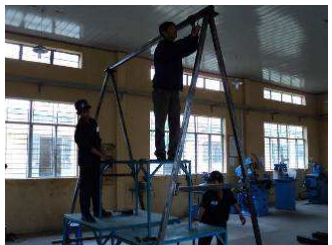
Photo 5: Testmontage des 500 Kg Kran
